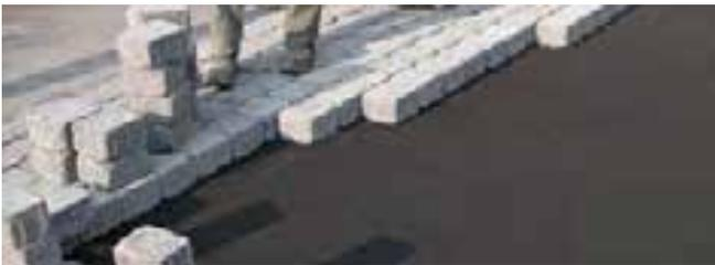
Eine weitere wichtige Aufgabe der Fuge ist es, die erlaubten Maßtoleranzen der Steine aufzunehmen und auszugleichen. Diese Aufgabe kann nicht erfüllt werden, wenn die Steine Beton an Beton „knirsch“ verlegt werden und sollte unbedingt vermieden werden, um Beschädigungen durch Kantenpressungen zu vermeiden.
