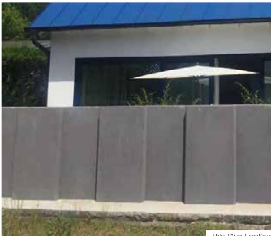
Die Betonstelen sind für den Außenbereich konzipiert und bieten verschiedene Gestaltungsmöglichkeiten. In einer versetzten Anordnung wirken sie im Vergleich zu einer Mauer leicht und grenzen trotzdem deutlich die gewünschten Bereiche ab. Mit diesem individuellen und flexibel anwendbaren Sichtschutz lässt sich die Privatsphäre wahren, und es können individuelle Zonen abgeschieden werden.
